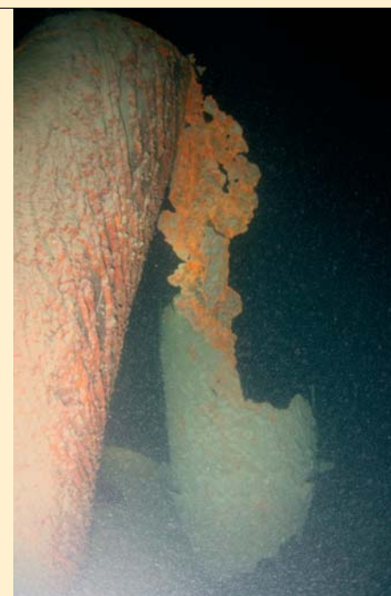
Danneggiato. Il fumaiolo caduto e arrugginito sul ponte
