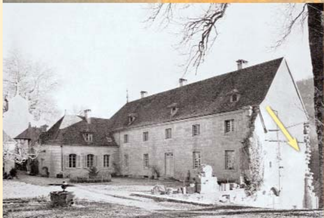
Quel che resta. La rottura del muro sul lato sud-ovest che dava sulla corte di ingresso
